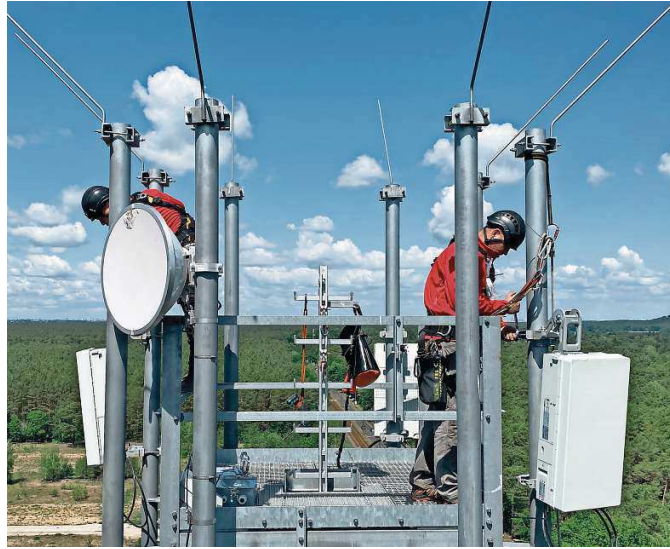
Arbeiter montieren Antennen für die fünfte Mobilfunkgeneration.
